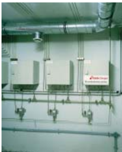
Uspořádání pneumatického zpoždění pro 4 hasební úseky
