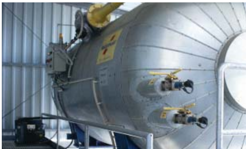
Zásobní kontejner CO 2 s elektronickou váhovou jednotkou ke kontrole úniku
