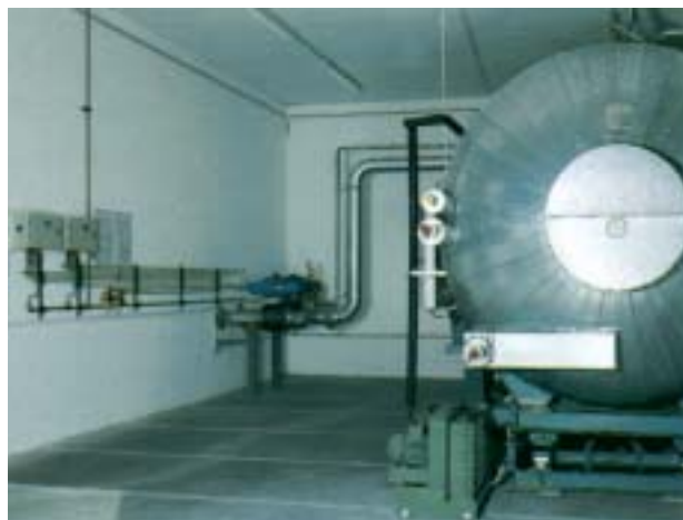
Nízkotlaké zařízení CO 2 s ústřednou, pneumatickým zpožďovacím zařízením a sekčními ventily
