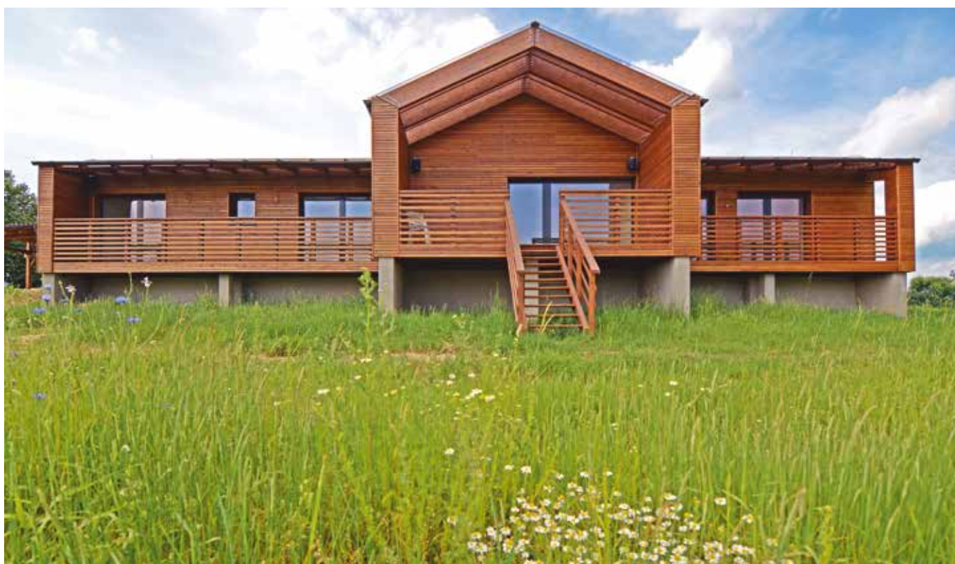
Fasáda Sibiřský modřín, profil Raute 28 x 68 mm, povrchová úprava OSMO – UV Ochranný olej č. 420 Bezbarvý, po 3 letech od aplikace
