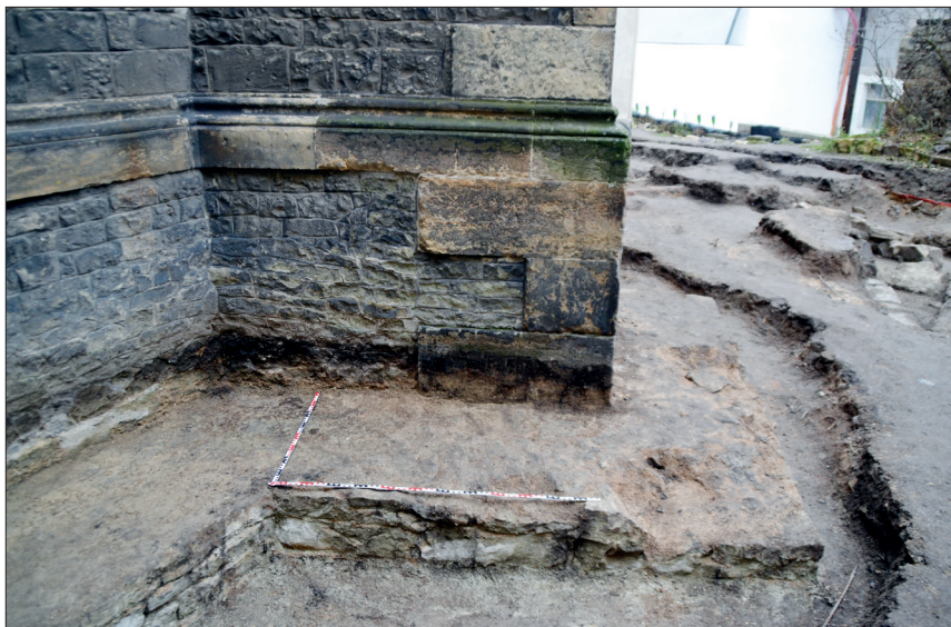
Obr. 6. Předzákladové mohutné zdivo u opěrného pilíře presbyteria, kde vystupuje o 80 cm od půdorysné dispozice nadzemní stavby kostela sv. Mikuláše; foto I. Peřina 2016.
