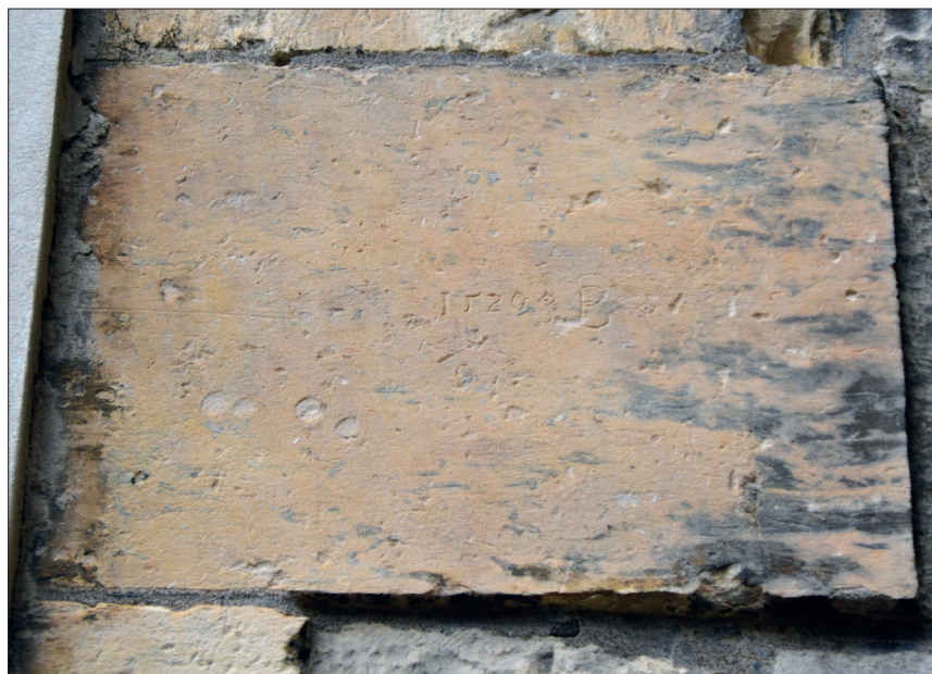
Obr. 7 Kvádr opěráku s letopočtem 1520, dokládající postup výstavby, vlevo navazující zdivo mladší barokní sakristie; foto I. Peřina 2016.
