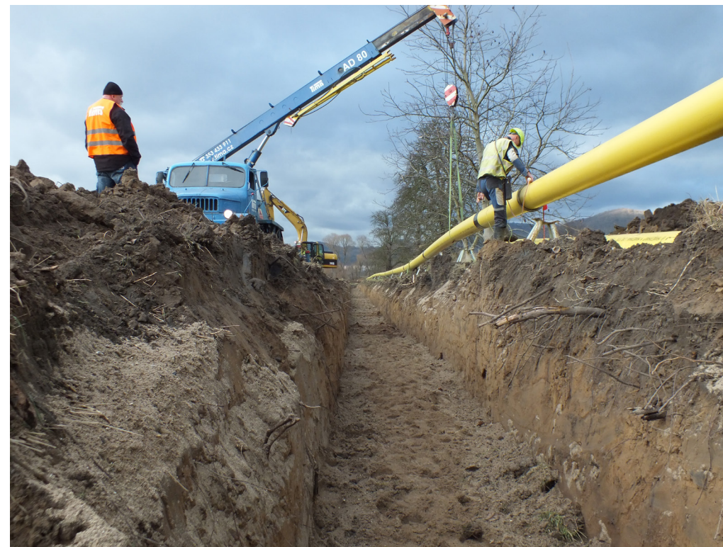
Pohled na průběh zemních výkopových prací (foto A. Káčerik)
