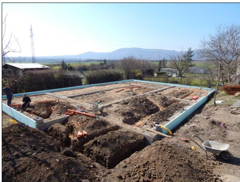
Obr. 3. Pohled na průběh zemních prací při hloubení základových pasů pro RD (foto A. Káčerik).
