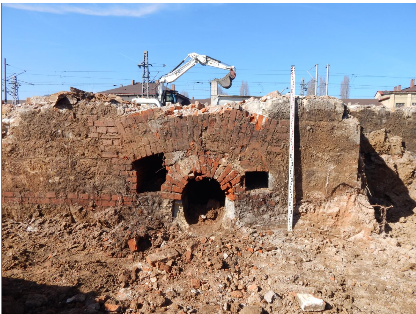
Obr. 05. Fotografická dokumentace cihlových zděných stavebních konstrukcí; foto A. Káčerik.
