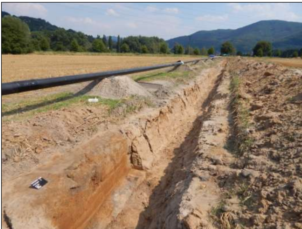
Obr. 08. Pohled od západu na výkopové práce (foto A. Káčerik).
