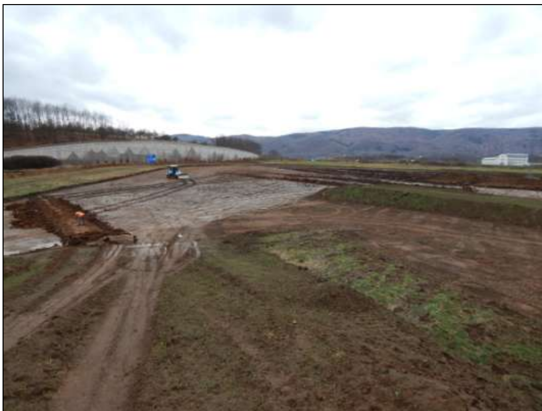
Obr. 09. Ověření terénní situace díky sondovacím rýhám provedenými mechanizací. Pohled od jihovýchodu směrem k dálničnímu exitu (Všebořice/Chlumec), foto A. Káčerik.
