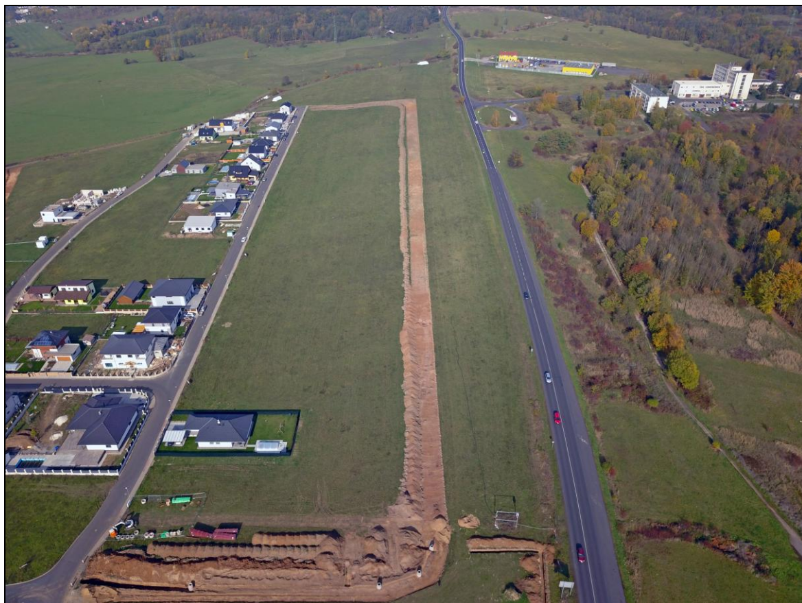
Obr. 09. Panoramatický pohled na lokalitu ve směru k obci Strážky při úpatí Krušných hor (snímek z dronu, autor D. Zaur).
